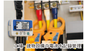
工場・建物設備の電流を記録管理
